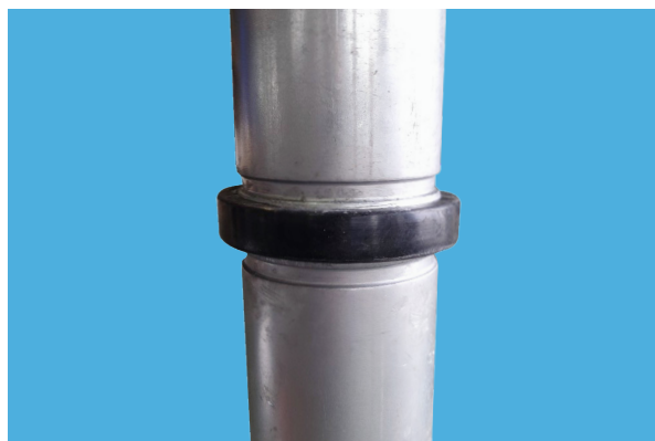
8. 그루빙작업이 끝난 파이프에 가스켓을 끼웁니다. 이때 주의 할 점은 파이프의 어긋으로 인하여 커플링 체결시 씹히지 않도록 해야 합니다.
