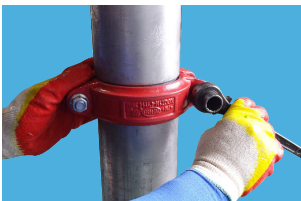
11. 양쪽에 위치한 볼트/너트를 균등히 조여가면서 서로 맞닿을 때까지 너트를 조여줍니다. 이때 주의 할 점은 가스켓이 씹히지 않도록 육안으로 확인하며 서서히 조여 주시기 바랍니다.
